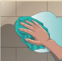
Nehmen Sie überschüssiges Imprägniermittel mit einem Tuch wieder auf. Angetrocknete Reste lassen sich mit frischem Imprägniermittel anlösen.
